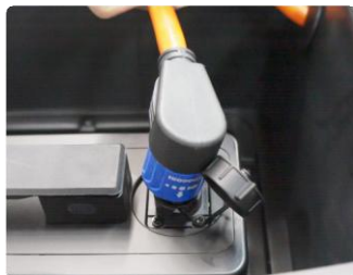
Remoção do cabo do ciclo elétrico da bateria
